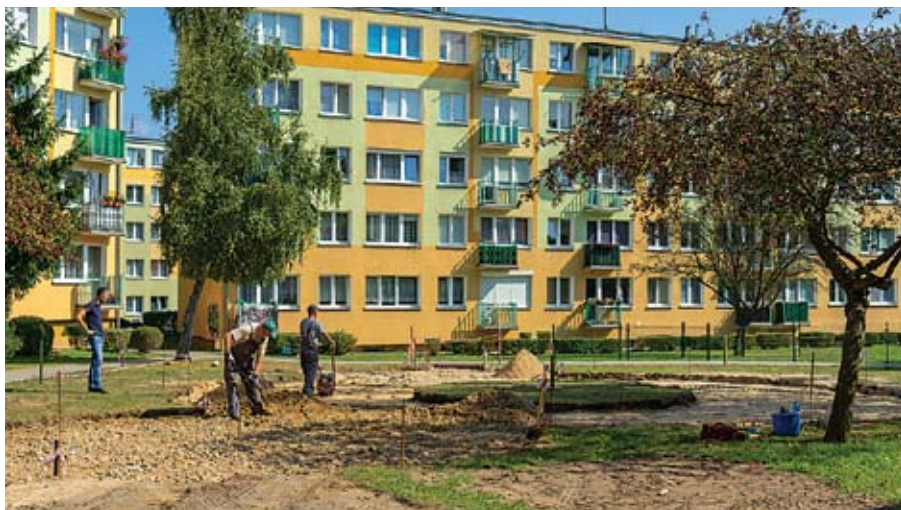
Budowa skwerku przy ul. Wyszyńskiego 8
