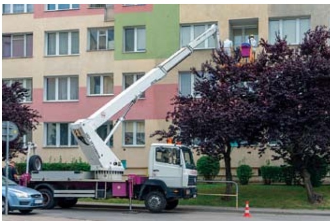
Mycie elewacji budynku
