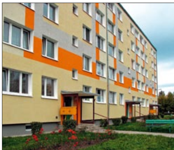
Nowe elewacje, wyremontowane klatki schodowe - z roku na rok poprawia się standard zasobów SM Pojezierze.
